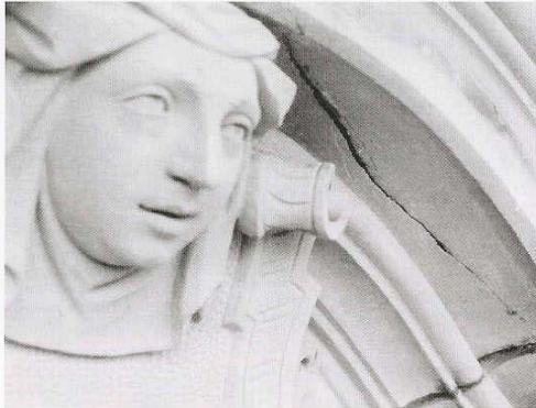
Schäden am Sandstein (z.B. Risse) und am Mörtel sind bei Dauerbeanspruchung unvermeidbar. BL zeigt hier eine perfekte Restauration von Fassadenelementen bis ins Detail am Beispiel einer Fensterverdachung aus Sandstein.
