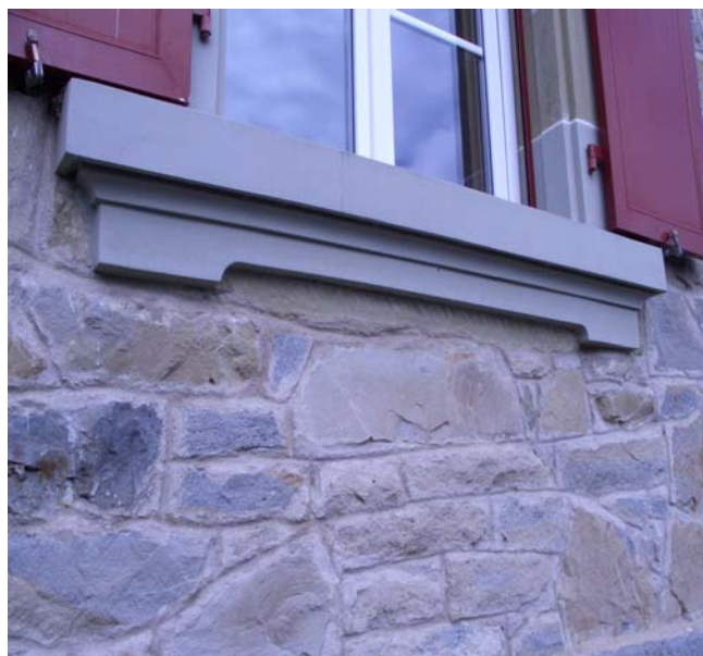
Reparierte Fensterumrandung Rebord de fenêtre réparé
