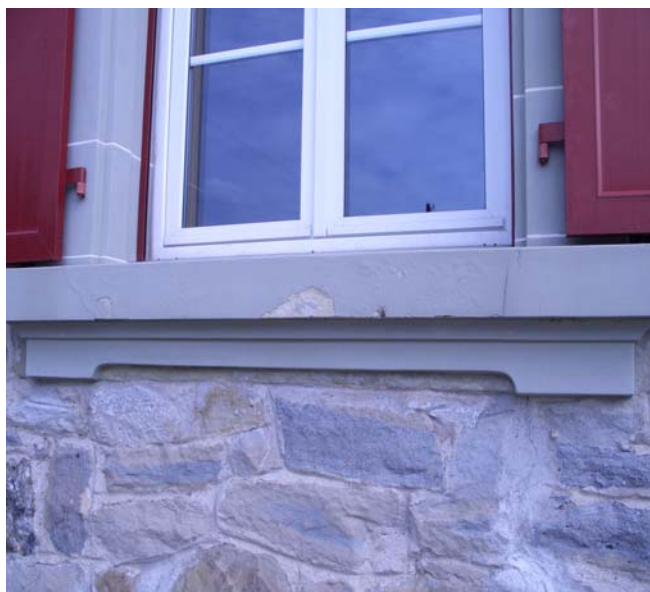
Zustand vor der Sanierung Avant les travaux
