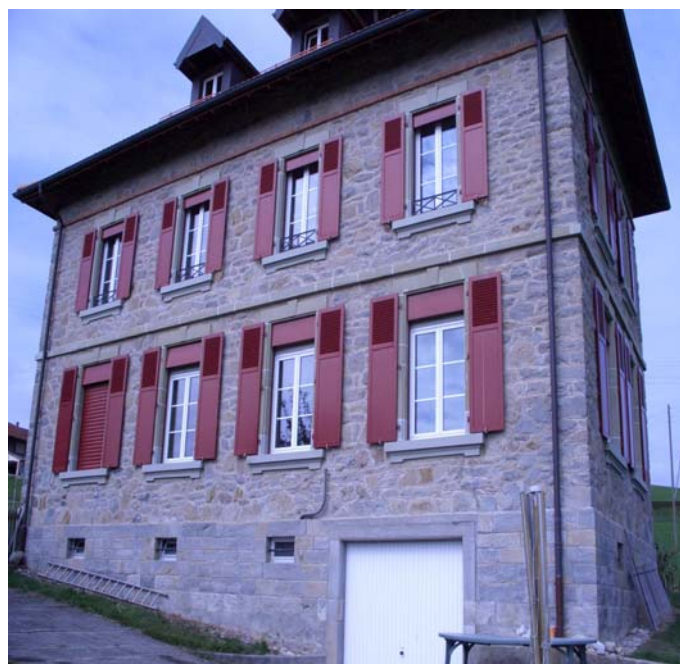
Après les travaux réalisés par l'entreprise Rémy Richard, Forel Eté 2003
