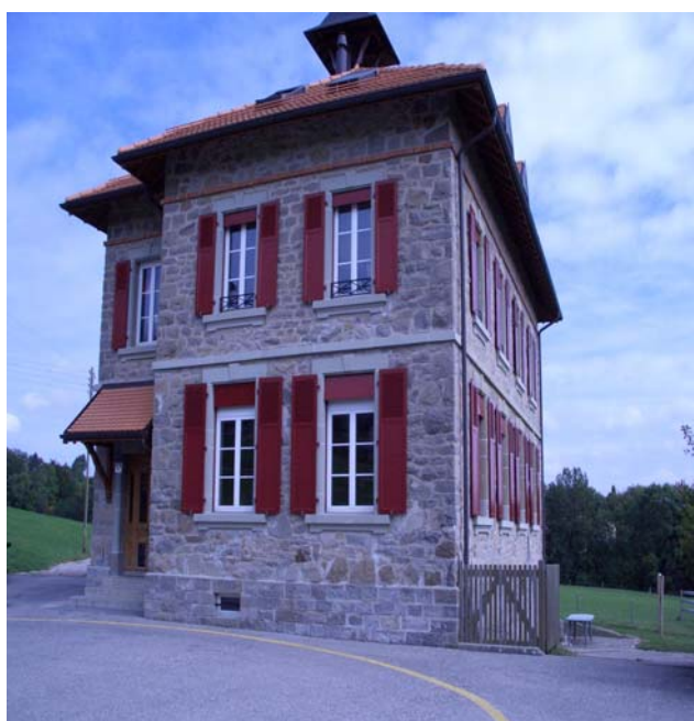
Nach der Sanierung durch Firma Rémy Richard, Forel Sommer 2003
