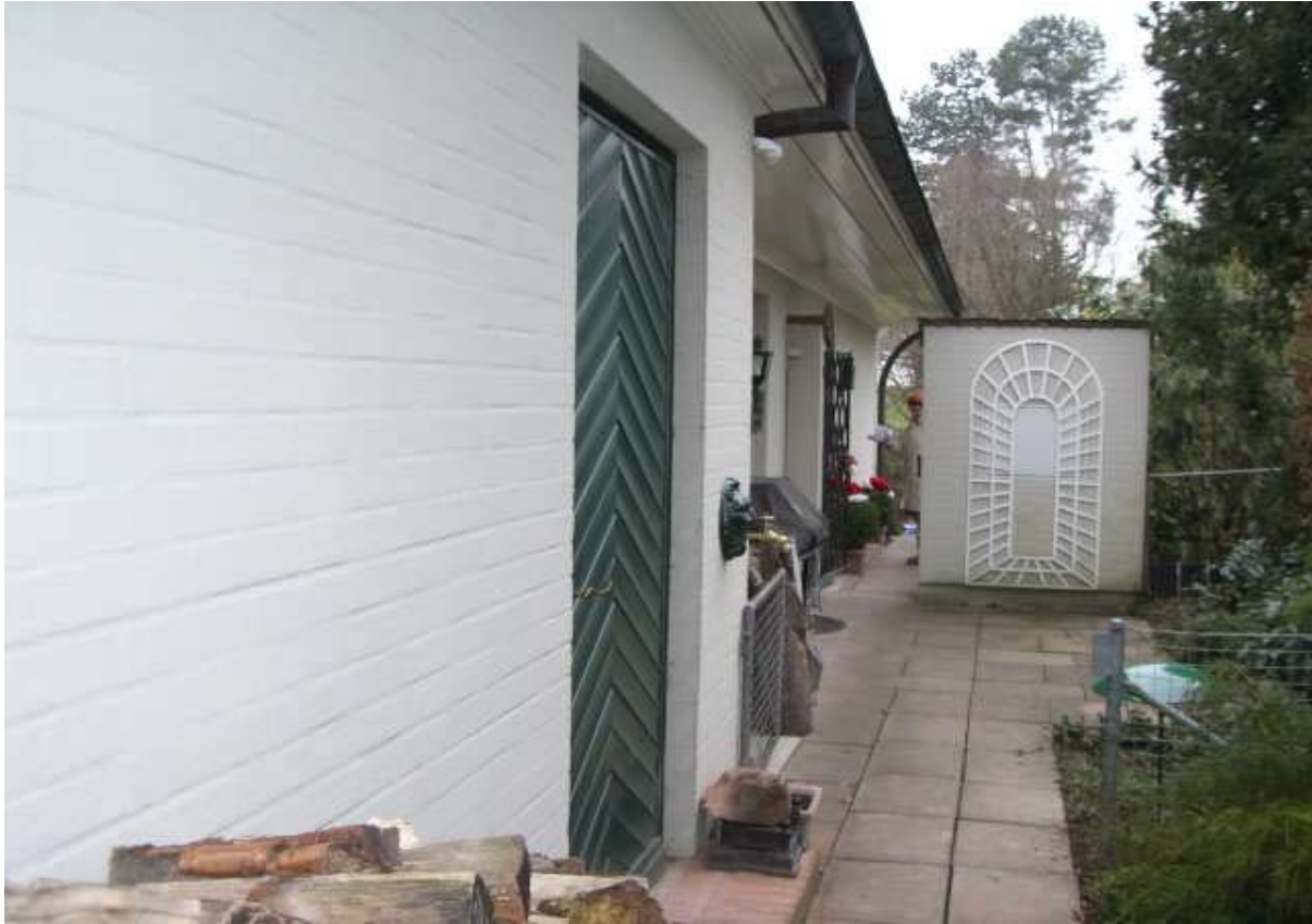
BL Fixschlämme, Farbton Nr. 50 – seit 1990 an der Fassade
